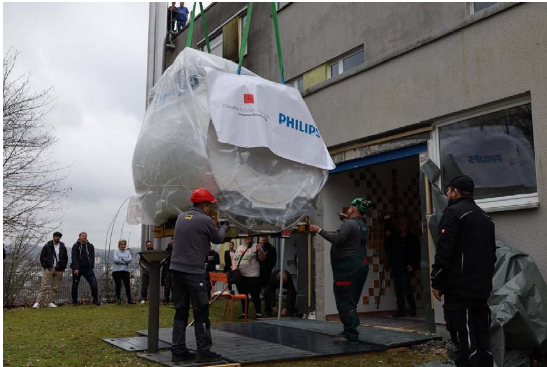
Bild vom MRT am Kran kurz vor der Einbringung
